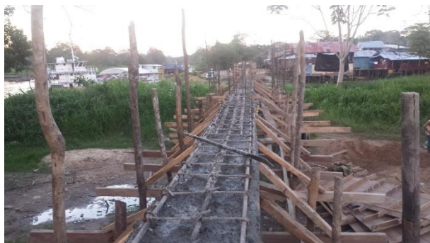
Colocación de concreto para viga aérea tramo 4
