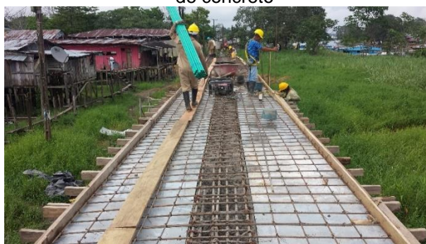
Refuerzo placa sendero tramo 3.
