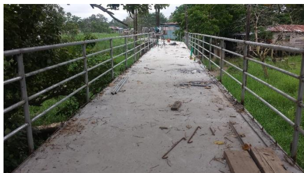
Instalación de barandas tramo 1
