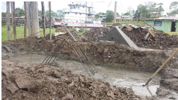
Refuerzo para anclaje P2B ( Puente colgante 2)
